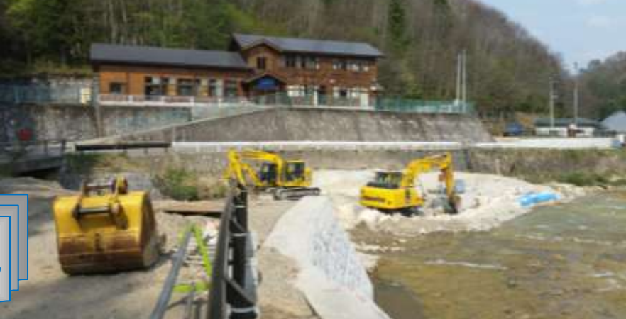
井戸沢橋橋脚の基礎床掘中
